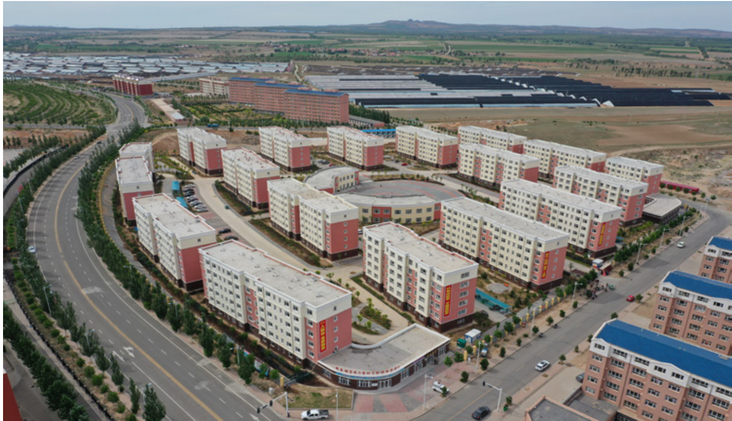
敖汉旗新惠镇易地扶贫搬迁安置区及后续设施农业扶贫产业园
