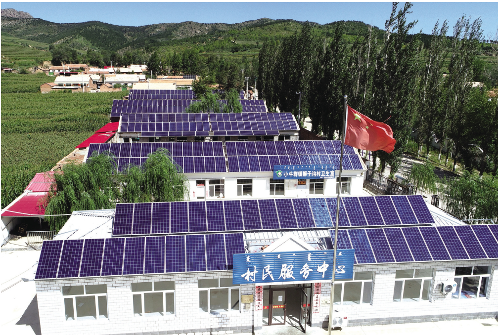
光伏——喀喇沁旗小牛群镇狮子沟村光伏脱贫产业基地
